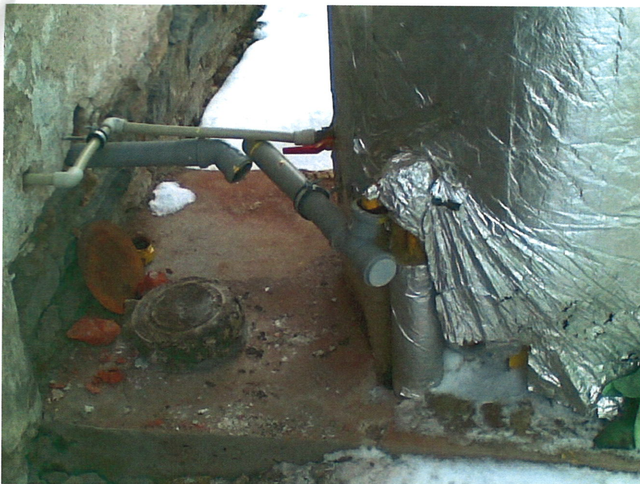
Detail provedení odlučovače vlhkosti
