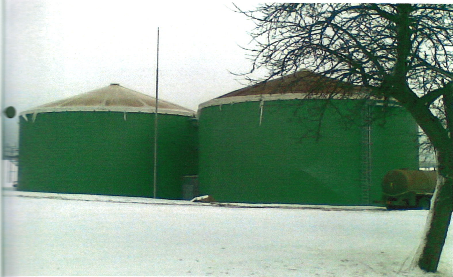
Pohled na BPS od komunikace z Habrů
